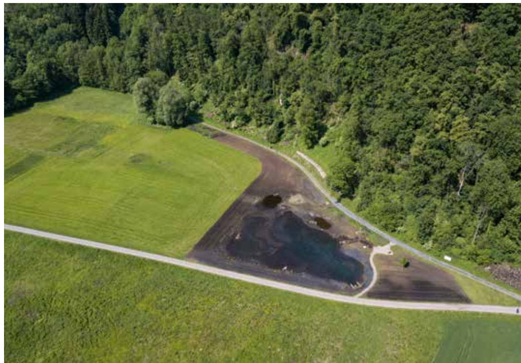
Blick auf die getätigte Etappe 1 und 2 der Biodiversitätsfläche. Zielarten sind die Bewohner von Wasserflächen und Schilfgürteln, Schmetterlinge der Feuchtstandorte sowie diverse Libellenarten.
